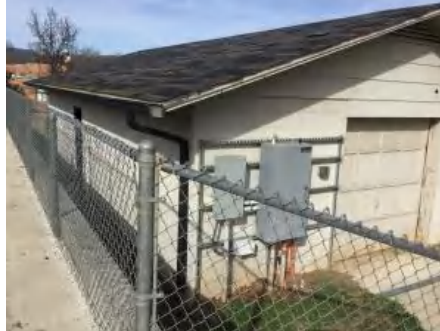
2). West Elevation - Feb 08, 2017
